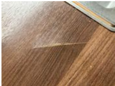
Skade i benkeplate
