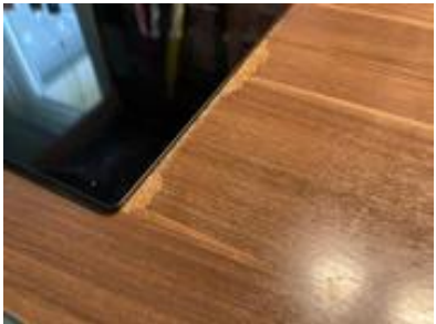
Skade i benkeplate
