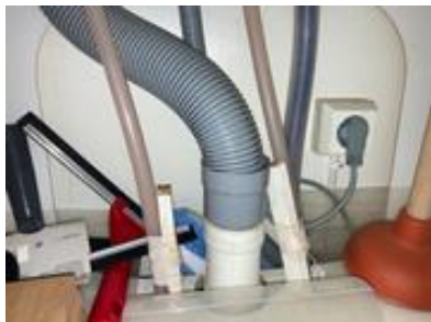
Skap med røropplegg i skap under vask
