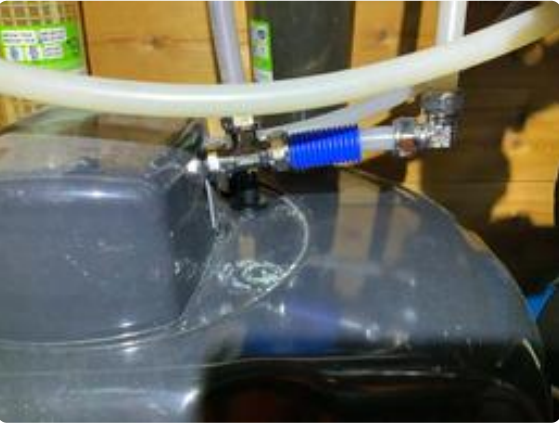
Plastrør direkte i bereder.
