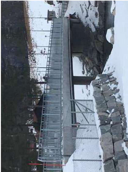
Eksempelbilde alternativ II, bru i plassstøpt betong, Eid kommune
