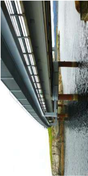
Eksempelbilde alternativ I, Myrbaekholmbua med påhengt gitterristbru på begge sider
