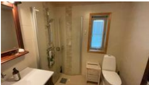
Vindu i våtsone til dusj.
