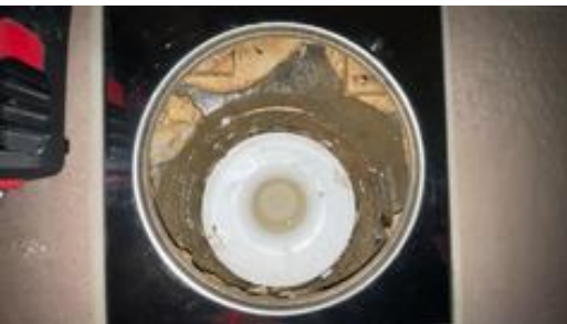
Plastsluk med synlig membran under klemring.
