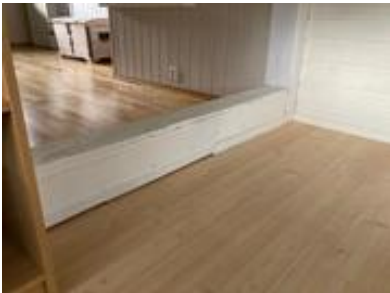
Bjelke på golv mellom rom - del av konstruksjon
