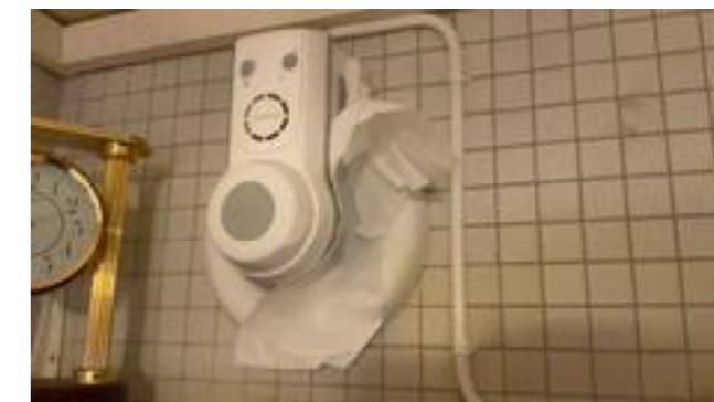
Vifte funksjonstestet med ppir.
