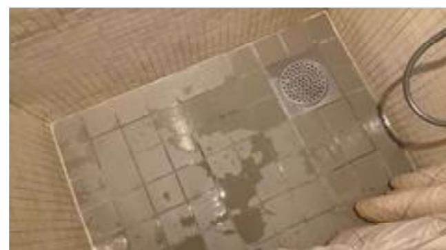
Ikke tilstrekkelig lokalt fall i dusjnisen
