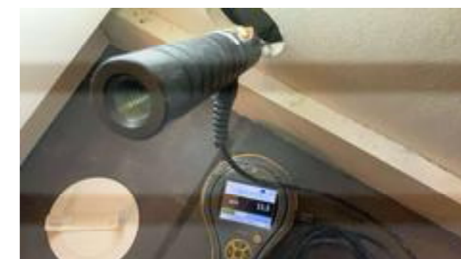
Fuktsøkt i vegg uten unormale forhold.
