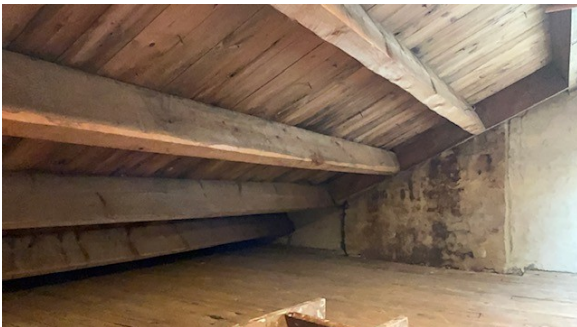
Takkonstruksjon med bærende bjelker (åser)
