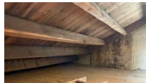
Takkonstruksjon med bærende bjelker (åser)
