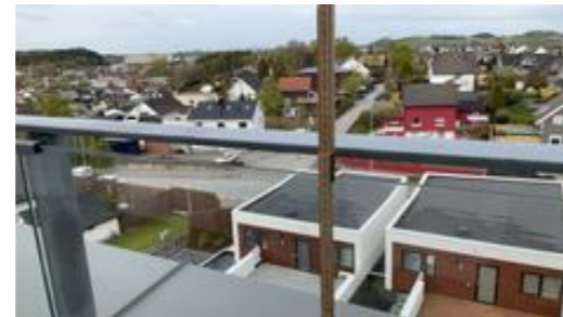
Rekkverk på balkong minimum 120 cm.
