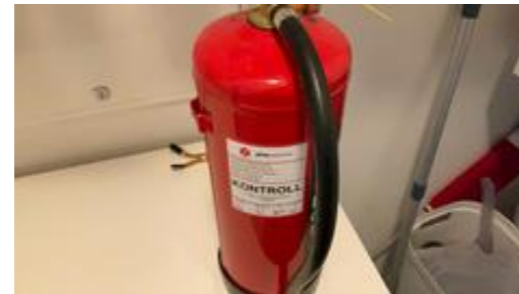
Brannslukkerapparat skal ha neste kontroll i 2029.
