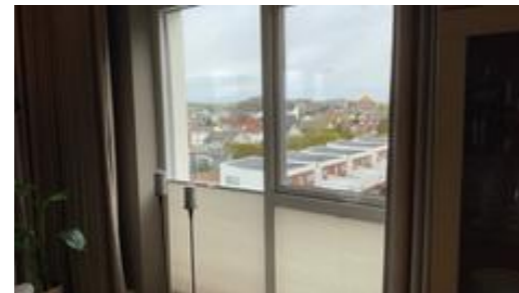
Vinduer i tre fra byggeår.
