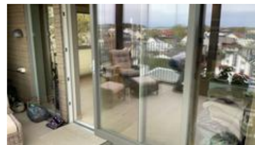
Skyvedør til innglasset balkong.
