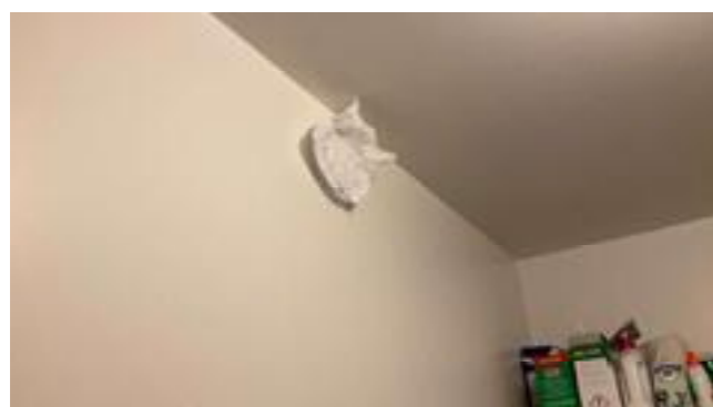
Avtrekk funksjonstestet med papir.
