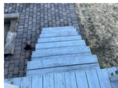
Tre trapp til balkong.
