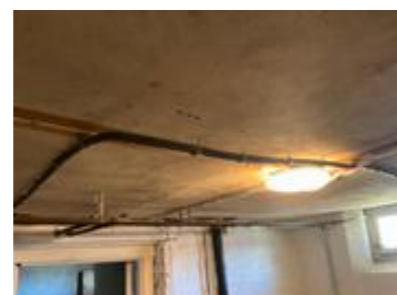
Løse ledning i himling i kjeller.
