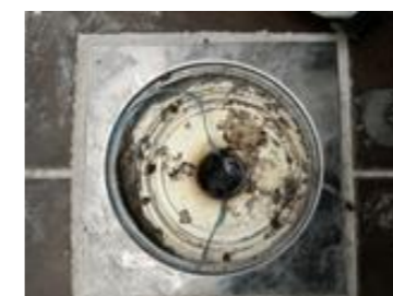
Oversiktsbilde av sluk.
