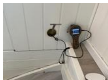
Fuktmåling uten utslag.
