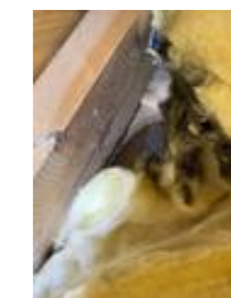
Manglende dampsperre mot oppvarmet rom.
