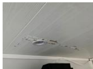
Bildet viser avflasket maling i tak.
