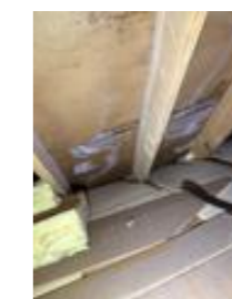
Manglende dampsperre mot oppvarmet rom.
