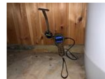
Fuktmåling uten utslag.
