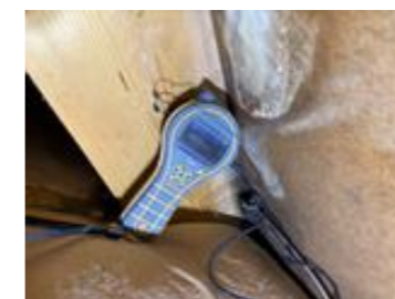
Fuktmåling i fuktskjolde uten utslag.
