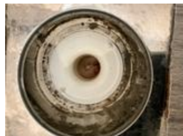
Oversiktsbilde av sluk.
