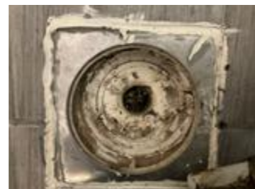
Oversiktsbilde av sluk.
