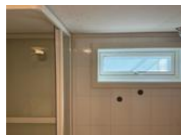
Vindu som er plassert i dusjens våtsone.
