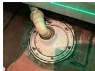
Oversiktsbilde av sluk.
