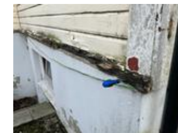
Råteskadet bunnstokk.
