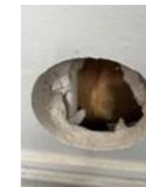
Fuktskole på bakside av plate for bad.
