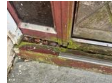
Råteskadet dørkarm.
