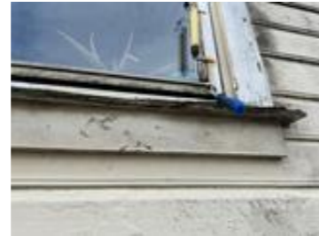
Råteskadet vinduskarm.
