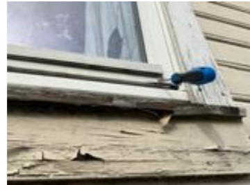
Råteskadet vinduskarm.
