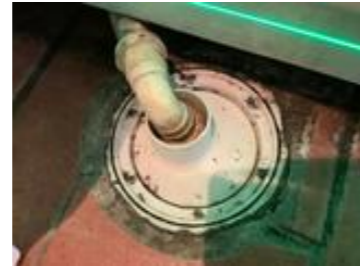
Oversiktsbilde av sluk.
