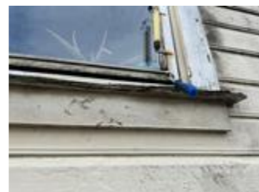
Råteskadet vinduskarm.
