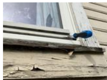
Råteskadet vinduskarm.
