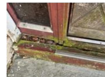
Råteskadet dørkarm.
