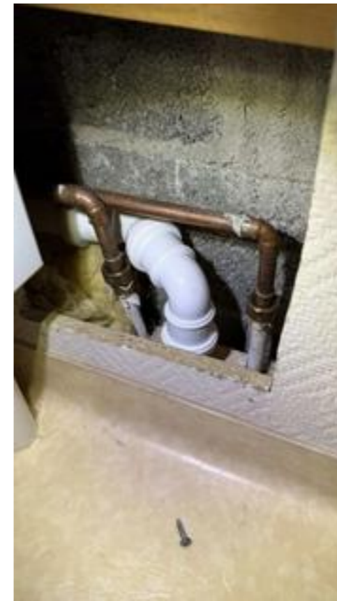
Eksempelbilde av åpning i vegg i våtsone.
