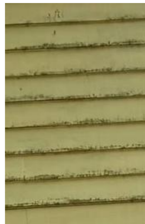
Eksempelbilde av slitasje/ svertesopp.
