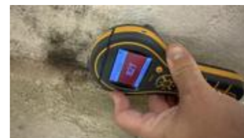
Eksempelbilde av indikasjoner på fukt.
