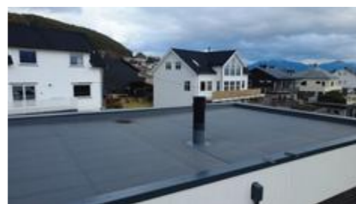
Pipe over tak. Stigesikring ved takkanten
