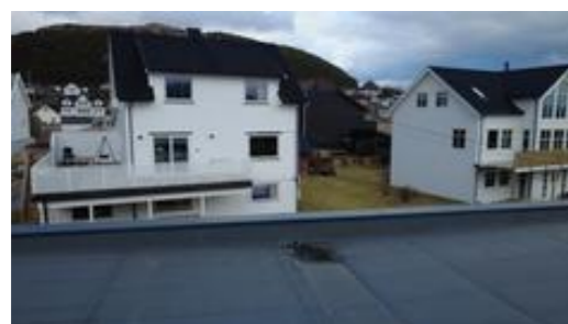
Taket er tekket med pvc takfolie
