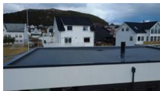
Taket er tekket med pvc takfolie
