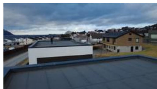
Taket er tekket med pvc takfolie
