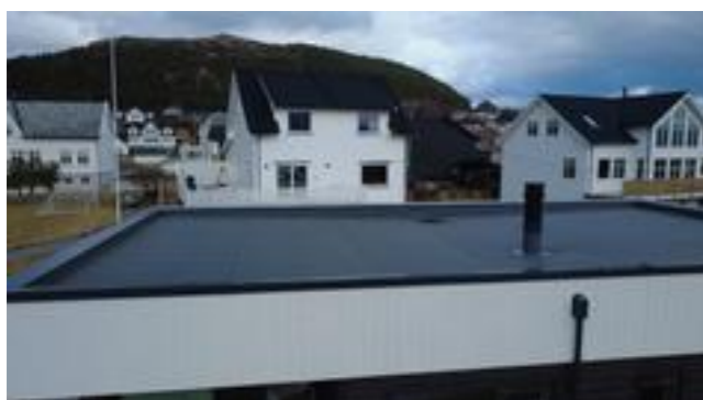
Taket er tekket med pvc takfolie
