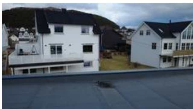
Taket er tekket med pvc takfolie
