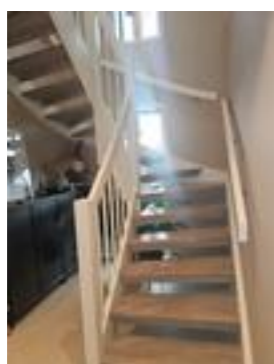
Innvendig trapp av tre mellom etasjene.
