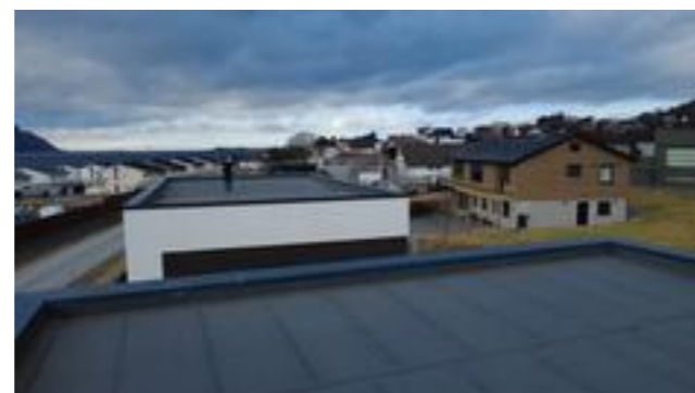
Taket er tekket med pvc takfolie
