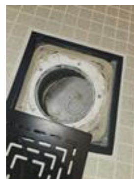
Plastsluk med mansjett og klemring
