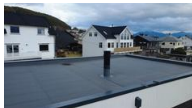
Pipe over tak. Stigesikring ved takkanten
