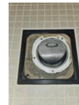
Plastsluk med mansjett og klemring
