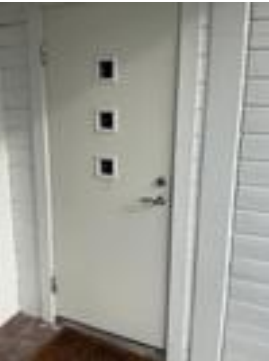
Hoveddør. Slitasje og begynnende råte på utvendig listverk
