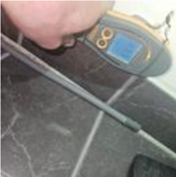
Fuktsøk på grunnmuren under terrenget
