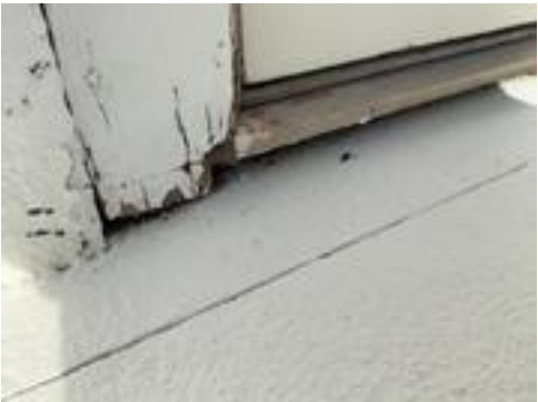
Hoveddør. Slitasje og begynnende råte på utvendig listverk
