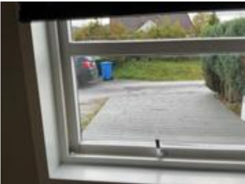
Vinduet i soverommet, fra innsiden
