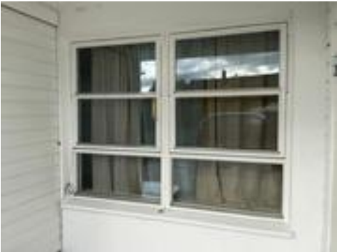
Vindu mot stuen
