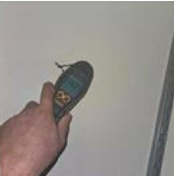
Fuktsøk på grunnmuren under terrenget
