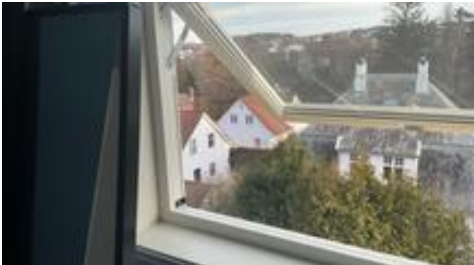
Glidehengslet rømningsvindu på loft.
