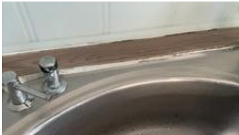
Underlimt vask som sprekker.
