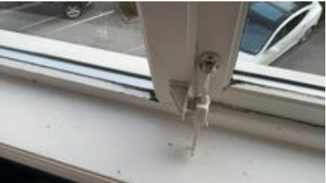
Generell slitasje/avflassing.
