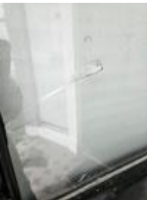
Det er påvist dører med punkterte eller sprukne glassruter.
