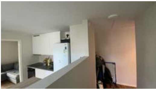
Pipe er innekledd i 1.etasje.
