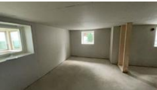
Rom under terreng, under oppgradering/oppbygging på befaringsdagen.
