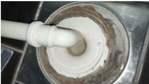
Sluk ved vaskemaskin uten klemring.
