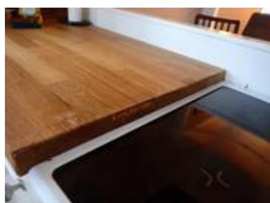
Skadet/løsnet endelaminat på benkeplate.
