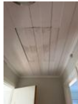
Enkel uisolert luke til kaldtloft
