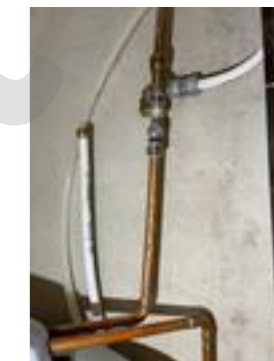
Hovedstoppekran bak skrudd plate i gang, Uetg.
