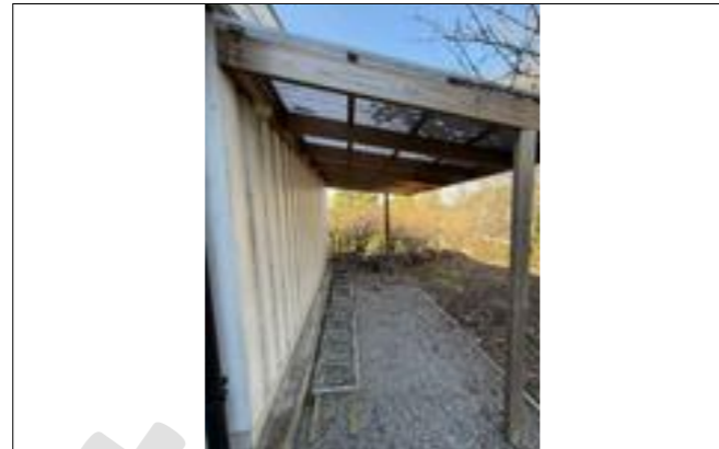
Sykkelparkering bak garasje
