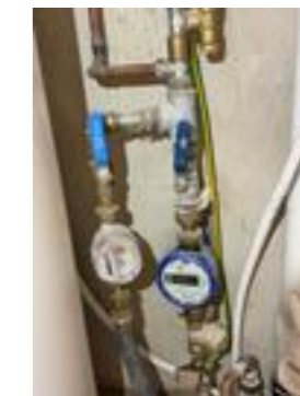
Hovedstoppekran bak skrudd plate i gang, Uetg.
