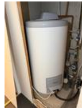
Bereider nr 1 bak skrudd plate i gang, Uetg.
