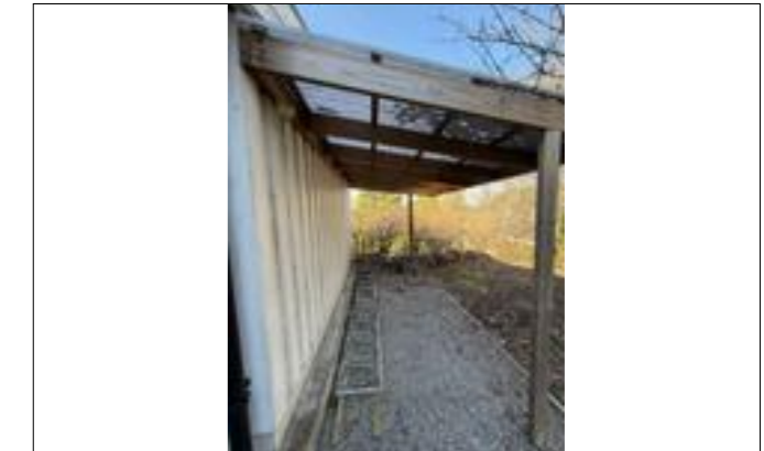
Sykkelparkering bak garasje
