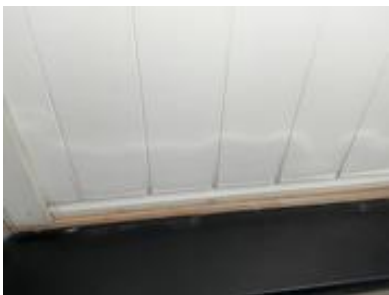
Nedre del av dørbladet på verandadøren er preget av fukt.
