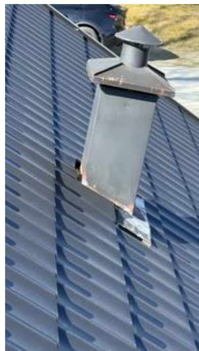
Eksempelbilde av slitasjegrad til takhatt.
