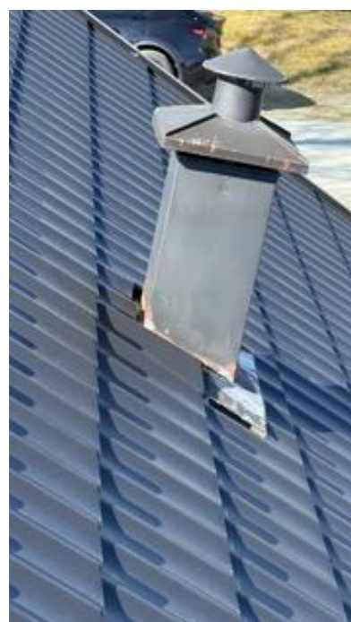
Eksempelbilde av slitasjegrad til takhatt.
