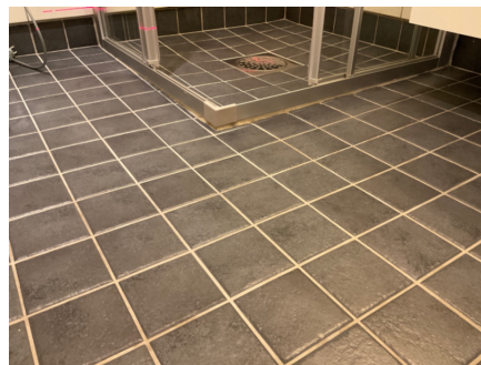
List med avgrensning mellom område med sluk og rommet forøvrig.
