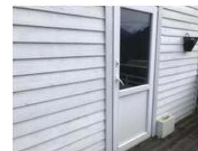
Nyere pvc balkongdør
