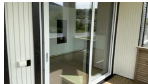
Skyvedør mot verandaen
