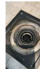
Plastluk med mansjett og klemring
