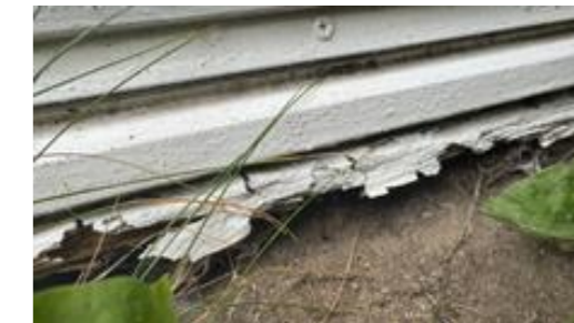
Råteskader
