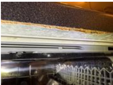
Røropplegg i kjøkkenbenk
