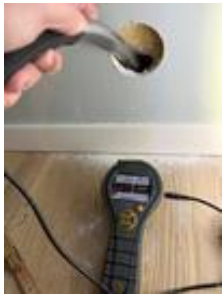
Hulltagning i bodvegg med pigger i svill.
