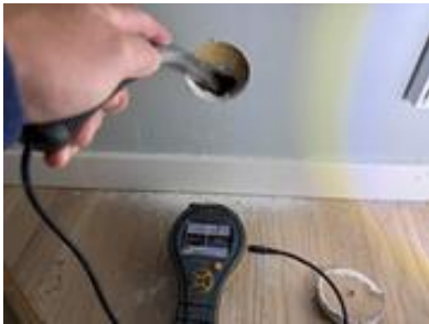
Hulltagning i kjøkkenvegg med pigger i svill.
