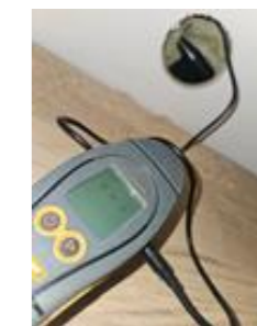
Ingen indikasjon på fukt i veggen
