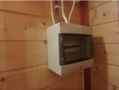
Boks med automatsikringer i gang på anneks 1.
