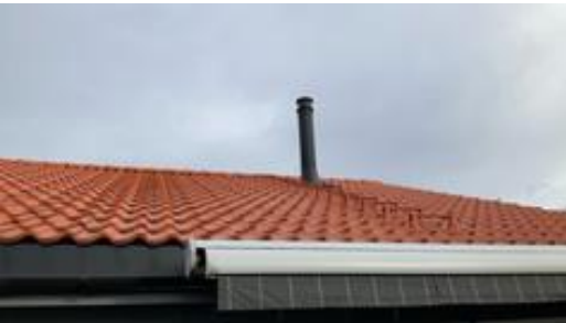
Betongtakstein fra ca 2015.
