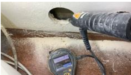
Fuktsøkt i vegg uten unormale forhold.
