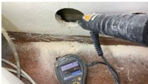
Fuktsøkt i vegg uten unormale forhold.
