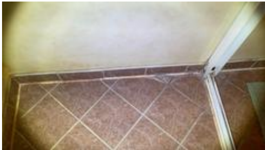
Merker, svertesopp og ugjevne mykfuger.
