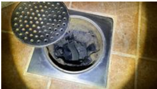
Sluk fra byggeår.
