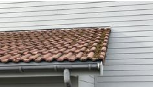
Betongtakstein på sportsbod.
