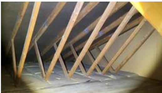
Saltak av takstoler.
