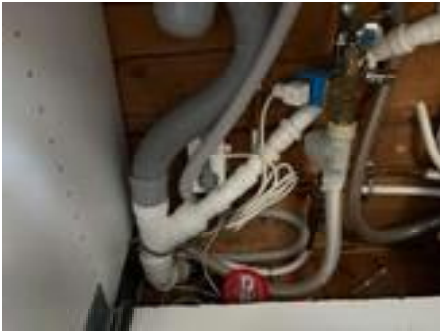
Bildet vise avløpsrør av plast som føres ned i bjelkelaget.
