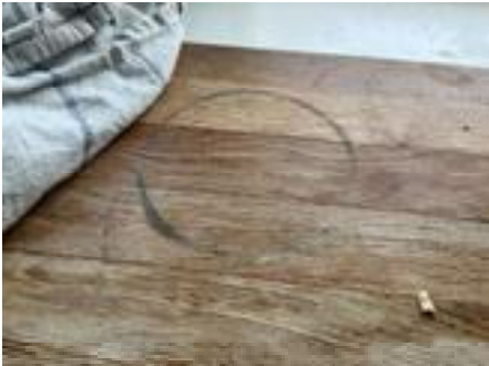
Gryte merke i benkeplate.
