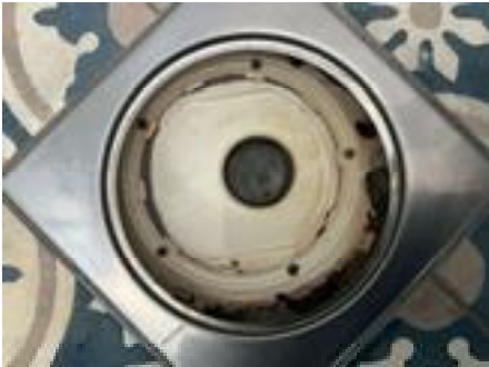
Oversiktsbilde av sluk.
