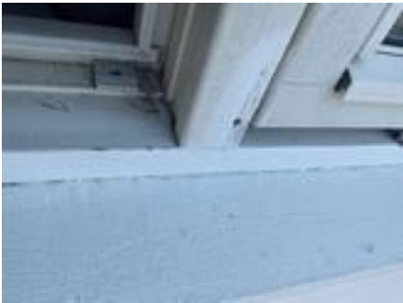
Råteskadet vinduskarm.
