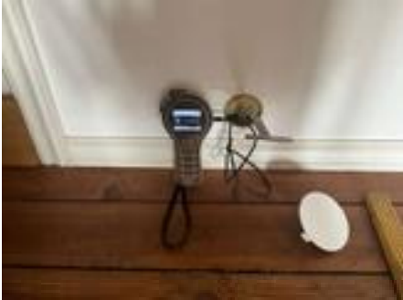
Fuktmåling uten utslag.
