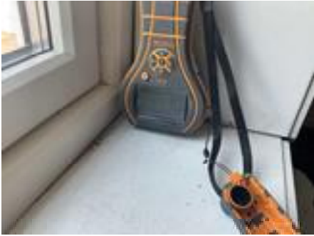
Fuktmåling uten unormale fuktverdier.
