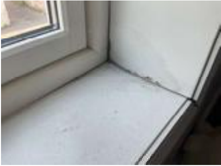
Råteskadet vinduskarm på soverom.
