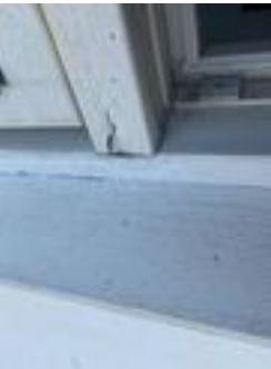
Råteskadet vinduskarm på soverom.
