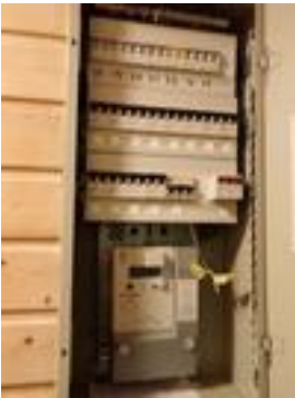
Skiftet til automatsikringer i sikringsskap
