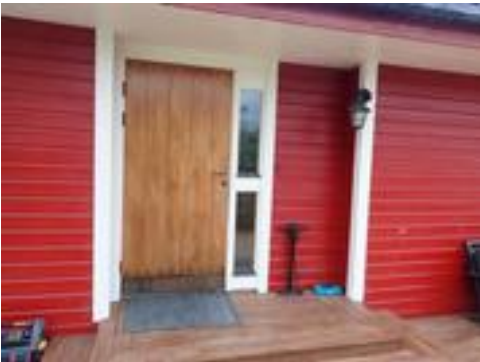
Slitt overflate ytterdør
