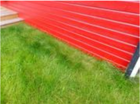
Kledning går helt til plennivå
