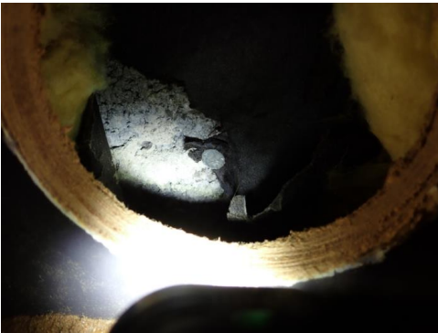
Det er brukt asfaltpapp på insiden av grunnmur
