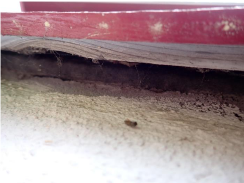
Ikke synlig musesperre og lite lufting
