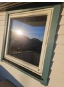
Vinduene har karmen av tre og isolerglass.
