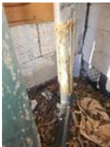
Takvannet mot øst ledes bort fra grunnmuren i et rør over terrenget
