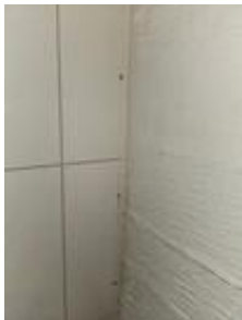
Platene er skrudd til underlaget. Ikke benyttet profiler el.
