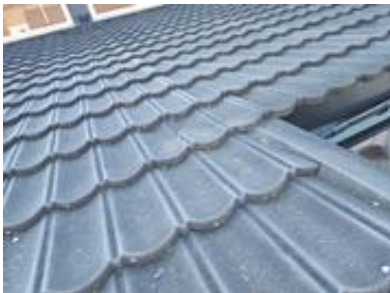
En bulket takpanne over kjøkkenet
