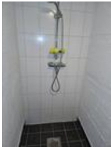
Dusj på vaskerommet. Baderomsplater på en vegg.
