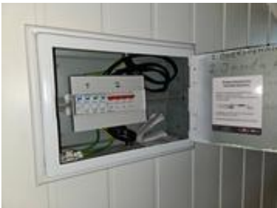
Sikringskap med automatsikringer
