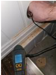
Ingen indikasjon på fukt i veggen
