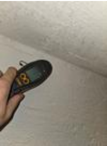
Søk med fuktindikator langs øvre del av veggen
