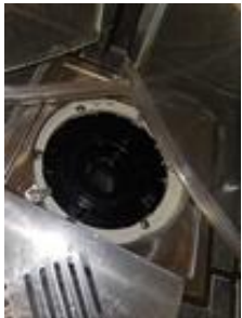
Plastsluk med mansjett og klemring
