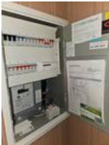
Sikringskap med automatsikringer
