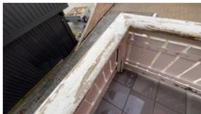
Værslitt rekkverk.
