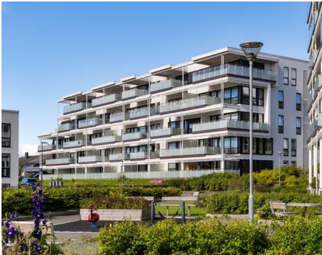
Boligen sogner til Åsvang barneskole og Hoeggen ungdomsskole.
