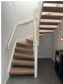
Innendig trapp av tre mellom etasjene.
