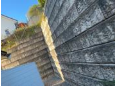
Støttemur av betongblokker
