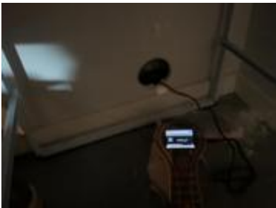
Ingen indikasjon på fukt i vegg
