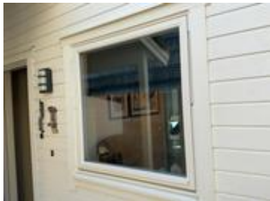
Vinduene har karmen av tre og tre lag isolerglass
