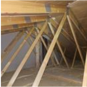
Saltak av fagverkskonstruksjon
