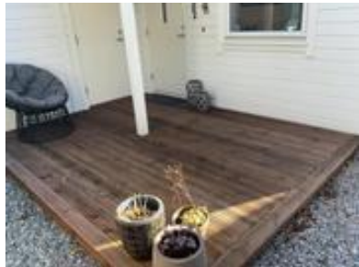
Terrasse ved inngangspartiet
