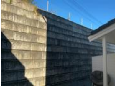
Støttemur av betongblokker
