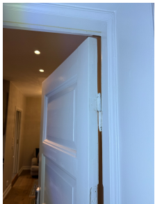
Original bakdør med moderne lås
