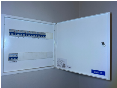
Automatsikringer med skap i stor hybel
