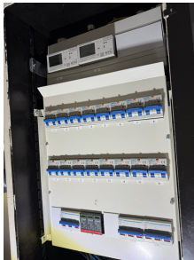
Automatsikringer med skap i omkleddingsrom. (trang adkomst)
