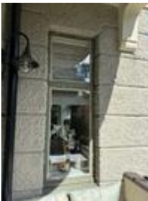
Opprinnlige vindu med nyere glass i karnapp og stor hybel
