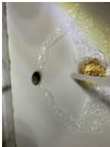
Servant er montert feil vei i skap-noe høyt vanntrykk i servanter
