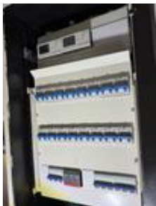
Automatsikringer med skap i omkleddningsrom. (trang adkomst)
