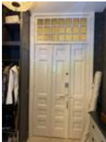
Original entredør med moderne lås
