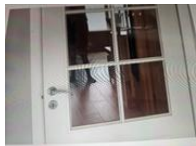
Vindusfelt i døren mellom gangen og stuen
