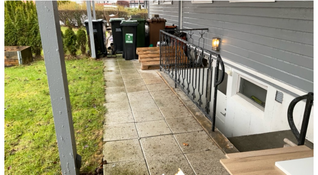
Fall på bakside med lite eller ingen fal fra mur.
