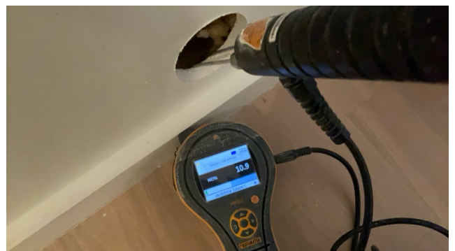
Fuktsøkt i vegg uten unormale forhold.
