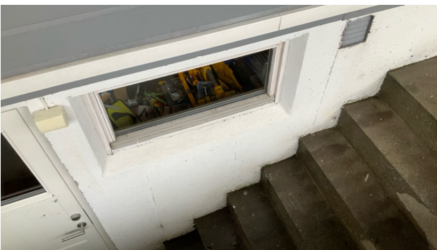
Grunnmur av betong.
