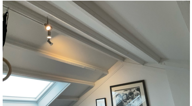
Takkonstruksjon kledd inne på loftsstue.
