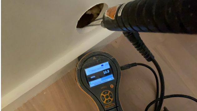
Fuktsøkt i vegg uten unormale forhold.
