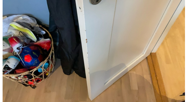
Bruksslitasjer/merker på innerdører/dørblad.
