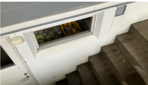
Grunnmur av betong.
