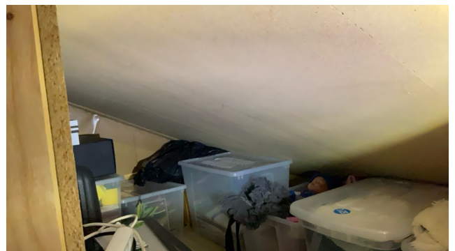
Takkonstruksjon kledd inne i knekott.
