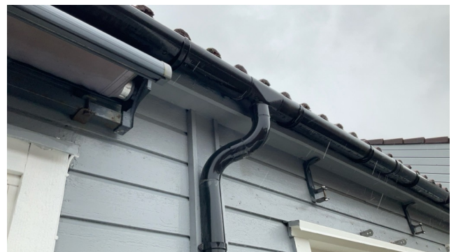
Takrenner/utstyr i aluminium.
