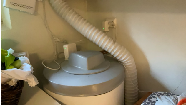
Varmtvannsbereder.
